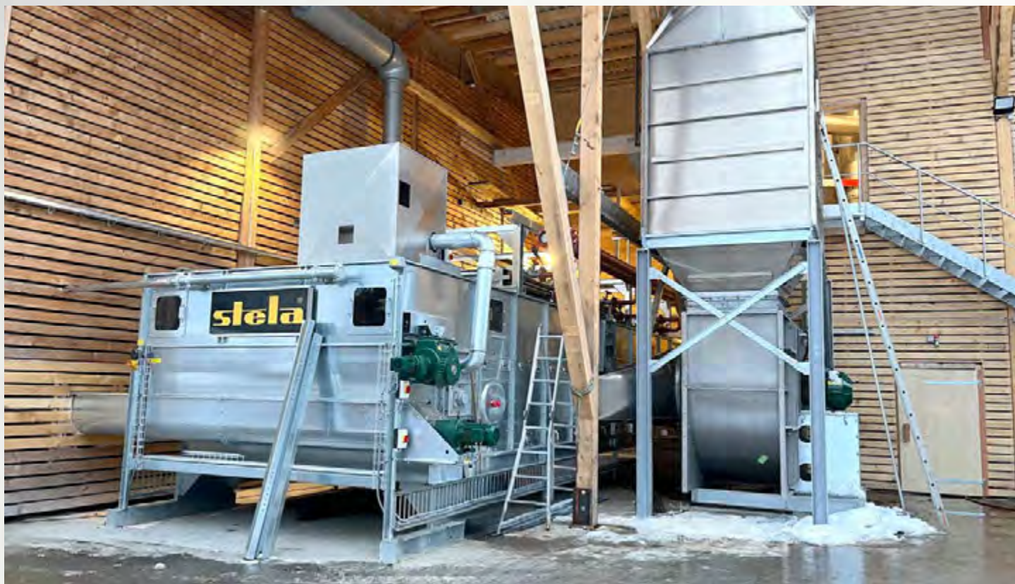
项目地：Energiepark z'Brigg, 瑞士 | 型号：BTL 1/3000-9 | 安装年份：2023 干燥物料：湿磨木屑 | 出料能力：约2.0吨/小时 | 降水区间：40% - 10%湿度
