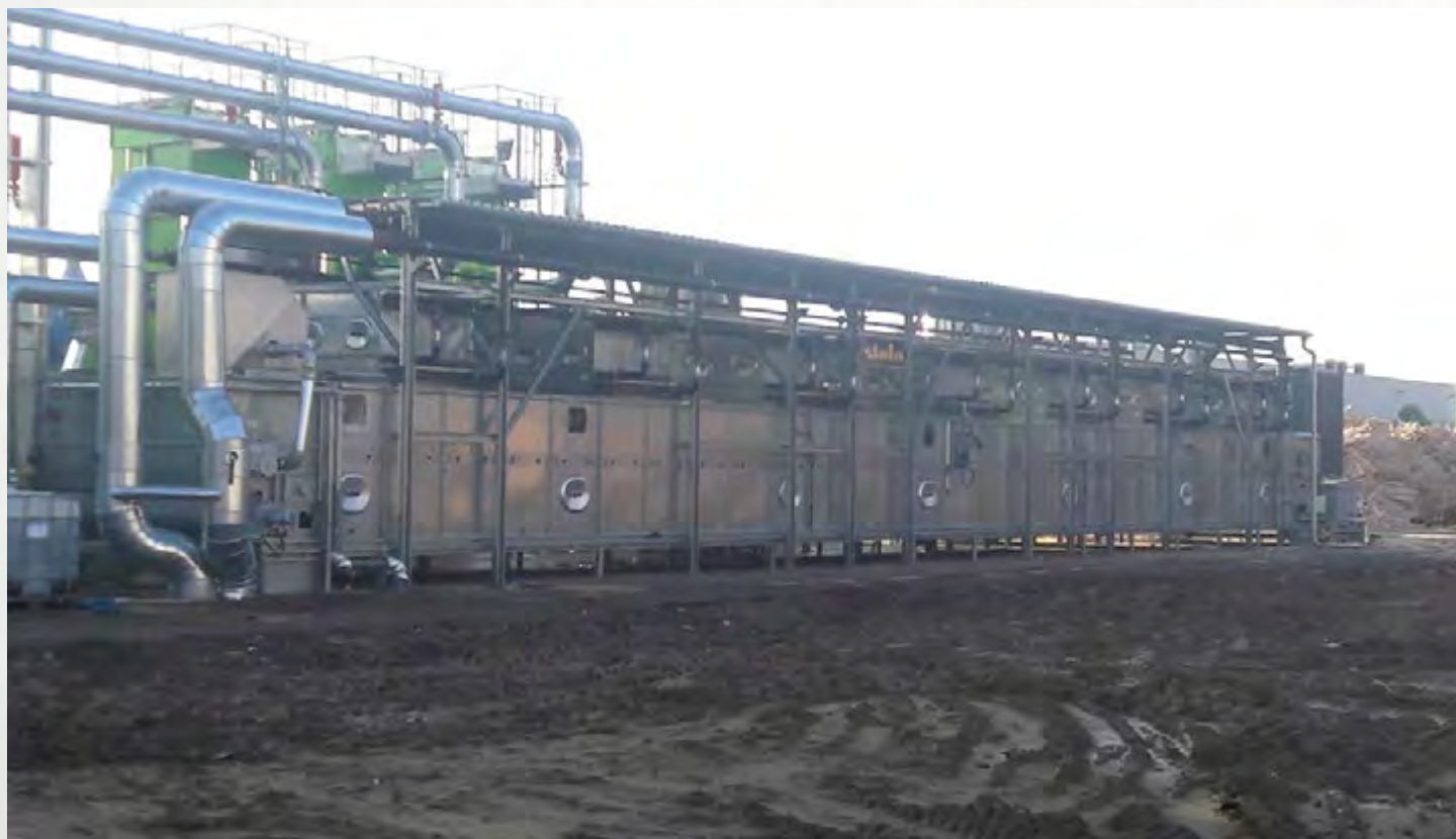
项目地：Mr. Garden, 波兰 | 型号：BTL 1/3000-29 | 安装年份：2017 干燥物料：木屑 | 出料能力：约6.0吨/小时 | 降水区间：50% - 10%湿度
