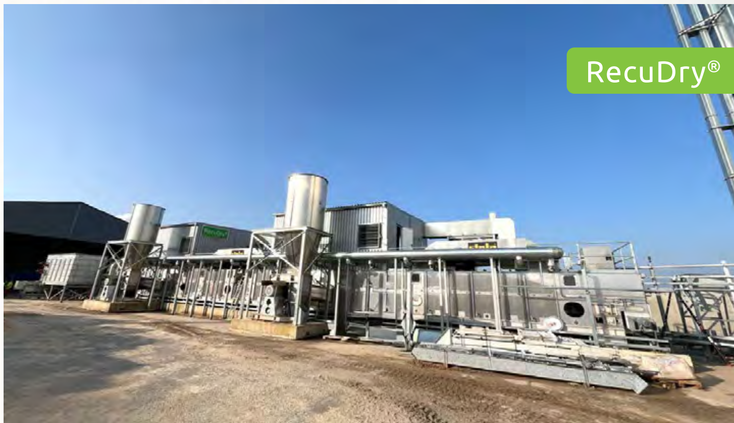
项目地：BSH Dabrowski, 波兰 | 型号：BTLU RecuDry 1/3000-32 | 安装年份：2023 干燥物料：木屑 | 出料能力：约5.0吨/小时 | 降水区间：50% - 10%湿度
