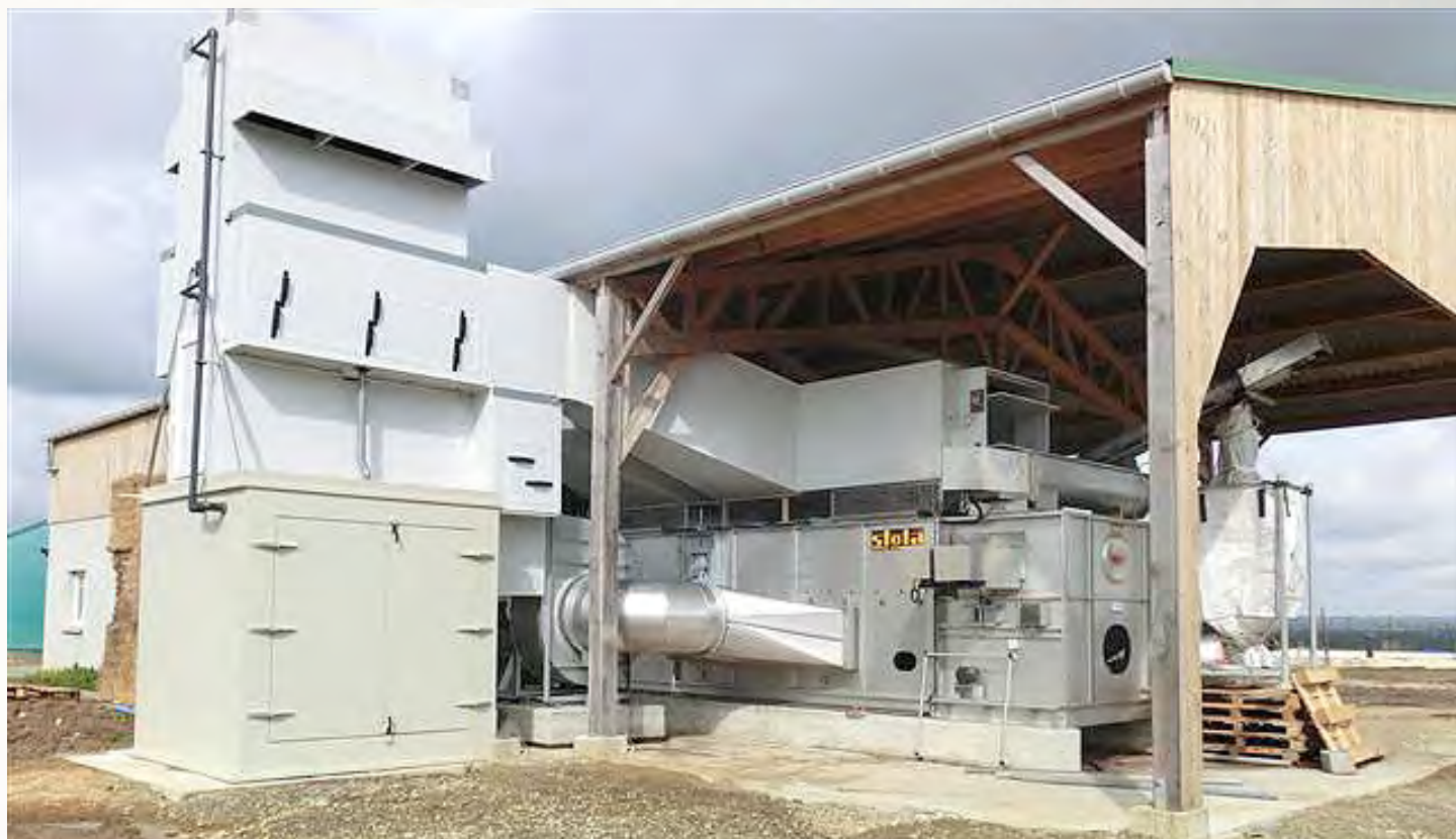
项目地：Earl de la Turmelière, 法国 | 型号：BTL 1/3000-6 | 安装年份：2012 干燥物料：消化污泥 | 出料能力：约0.03吨/小时 | 降水区间：92% -20%湿度
